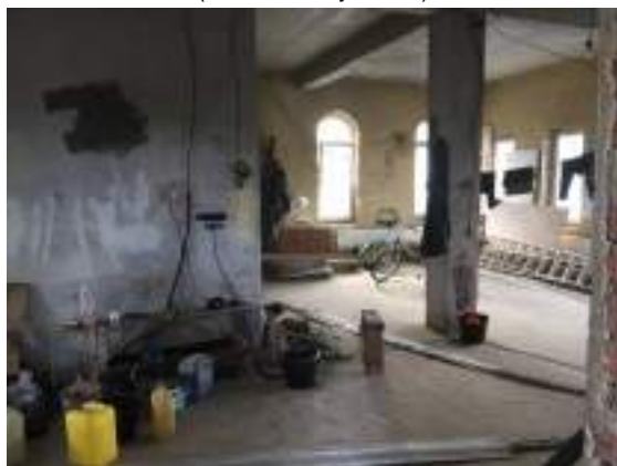
Фото 5. Внутренний вид здания (помещения 1 этажа)
