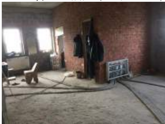
Фото 7. Внутренний вид здания (помещения 2 этажа)
