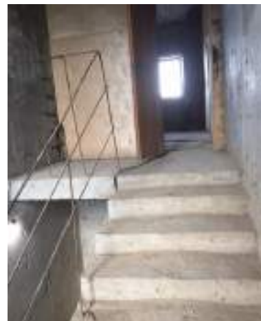
Фото 10. Внутренний вид здания (лестница главная)
