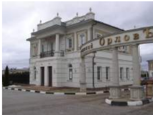
Фото 2. Внешний вид здания и прилегающей территории (земельного участка)
