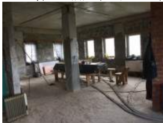
Фото 8. Внутренний вид здания (помещения 2 этажа)
