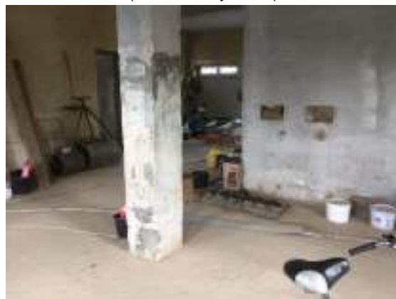
Фото 6. Внутренний вид здания (помещения 1 этажа)
