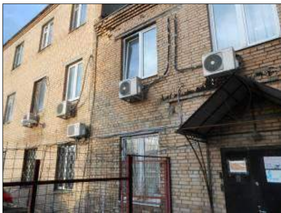
Фото 9. Здание: контора-общезитие, общая площадь 1 102,40 кв. м, инв. № 2-4194-А, Б, лит. А, Б.
