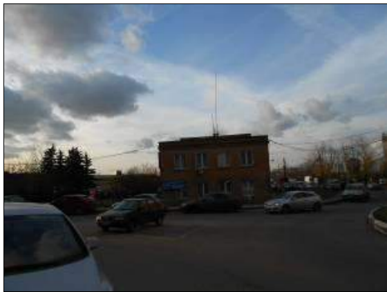
Фото 5. Здание: контора-общезитие, общая площадь 1 102,40 кв. м, инв. № 2-4194-А, Б, лит. А, Б.
