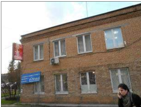
Фото 6. Здание: контора-общезитие, общая площадь 1 102,40 кв. м, инв. № 2-4194-А, Б, лит. А, Б.
