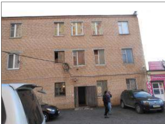
Фото 8. Здание: контора-общезитие, общая площадь 1 102,40 кв. м, инв. № 2-4194-А, Б, лит. А, Б.
