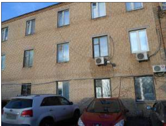
Фото 10. Здание: контора-общезитие, общая площадь 1 102,40 кв. м, инв. № 2-4194-А, Б, лит. А, Б.
