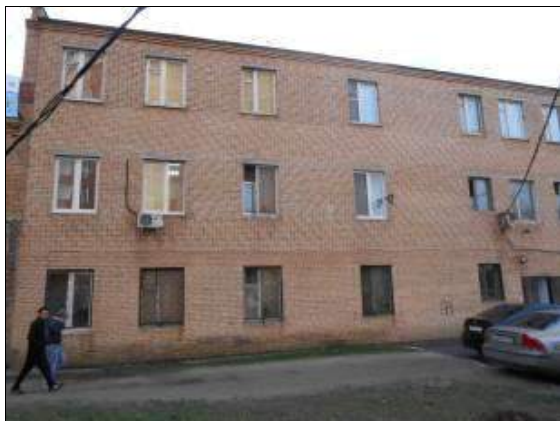
Фото 7. Здание: контора-общезитие, общая площадь 1 102,40 кв. м, инв. № 2-4194-А, Б, лит. А, Б.
