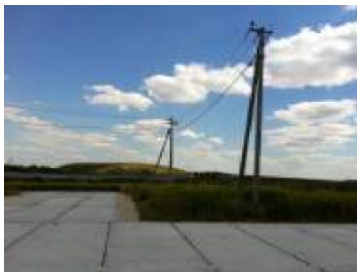
Фото 5. Подъездные пути к объектам оценки
