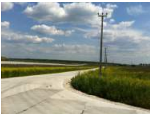
Фото 7. Подъездные пути к объектам оценки
