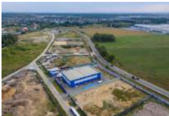
Фото 9. Подъездные пути к объектам оценки
