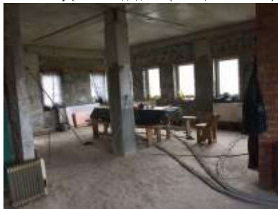
Фото 8. Внутренний вид здания (помещения 2 этажа)
