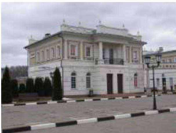
Фото 3. Внешний вид здания и прилегающей территории (земельного участка)
