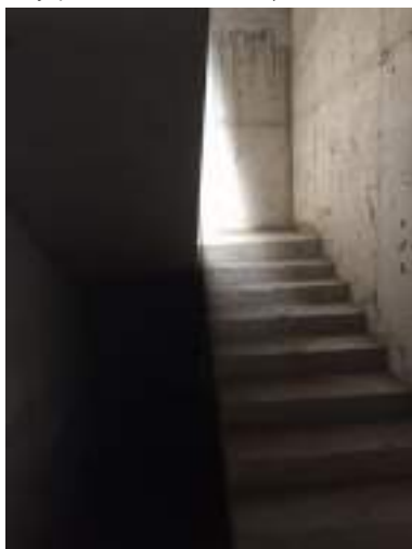
Фото 9. Внутренний вид здания (лестница главная)
