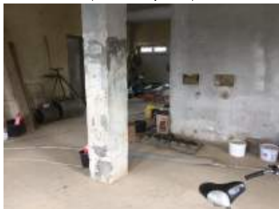
Фото 6. Внутренний вид здания (помещения 1 этажа)
