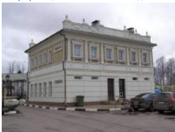
Фото 1. Внешний вид здания и прилегающей территории (земельного участка)
