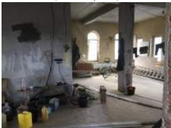
Фото 5. Внутренний вид здания (помещения 1 этажа)
