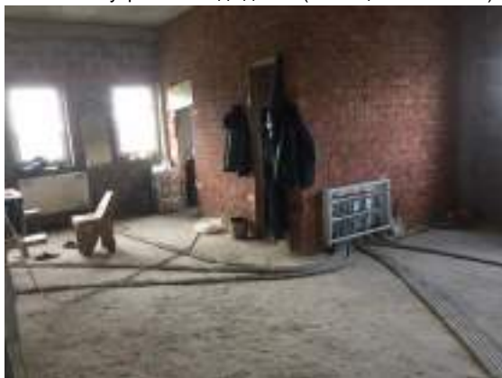
Фото 7. Внутренний вид здания (помещения 2 этажа)
