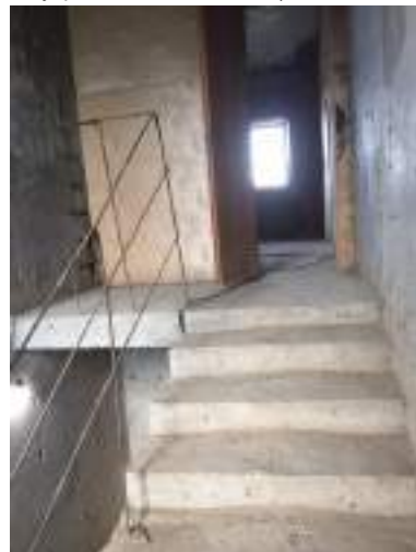
Фото 10. Внутренний вид здания (лестница главная)
