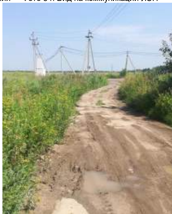
Фото 56. Вид на дорогу
