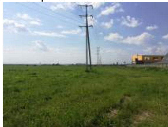
Фото 46. Вид на участок и ЛЭП
