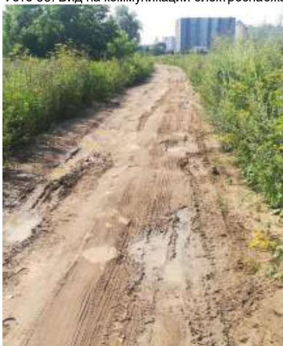
Фото 55. Вид на дорогу
