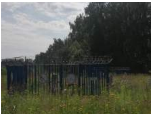
Фото 5. Вид на проходящие коммуникации - газ
