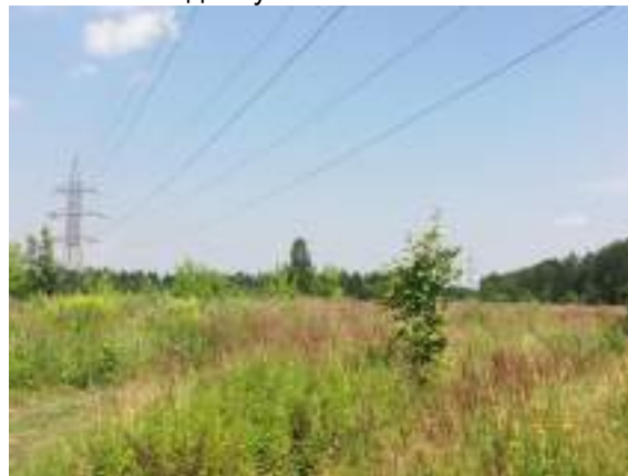
Фото 38. Вид на проходящие коммуникации - ЛЭП
