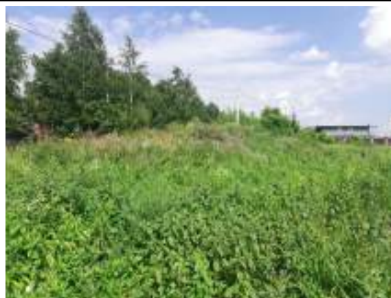
Фото 14. Вид на проходящие коммуникации – ЛЭП
