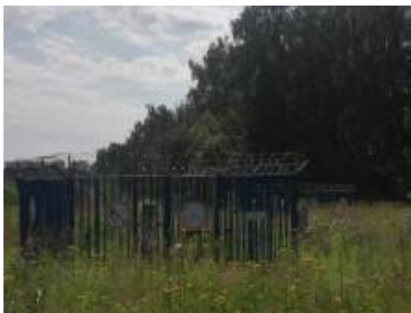
Фото 5. Вид на проходящие коммуникации - газ
