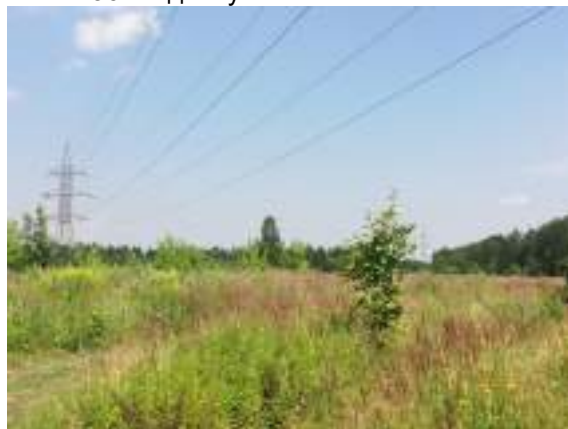
Фото 38. Вид на проходящие коммуникации - ЛЭП
