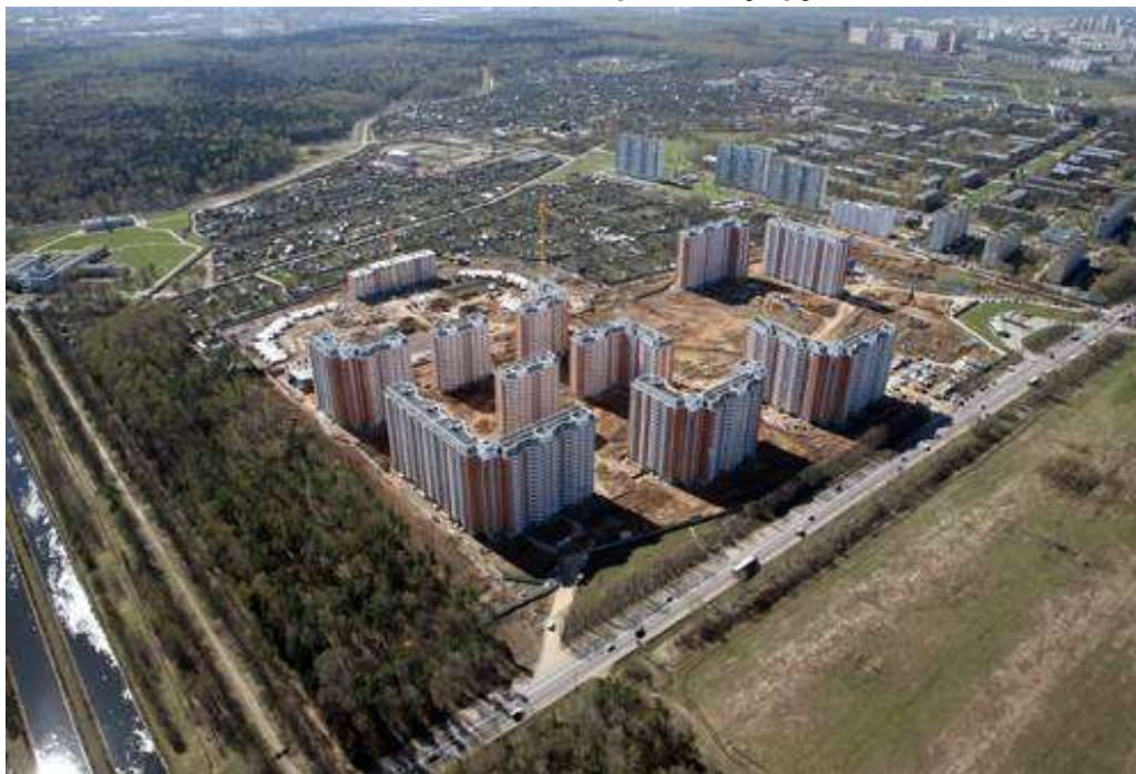
Внешний вид многоэтажного жилого дома №2:
