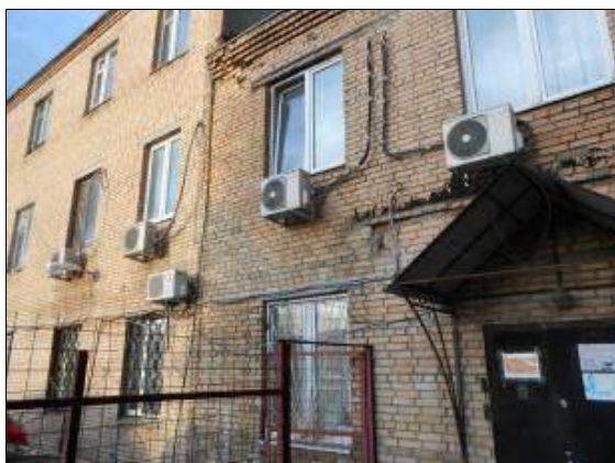
Фото 9. Здание: контора-общежитие, общая площадь 1 102,40 кв. м, инв. № 2-4194-А, Б, лит. А, Б.
