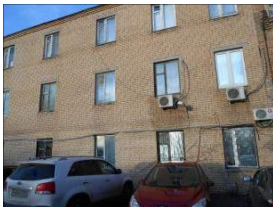
Фото 10. Здание: контора-общежитие, общая площадь 1 102,40 кв. м, инв. № 2-4194-А, Б, лит. А, Б.
