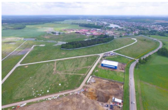
Фото 1. Общий вид территории, на которой находятся оцениваемые объекты
