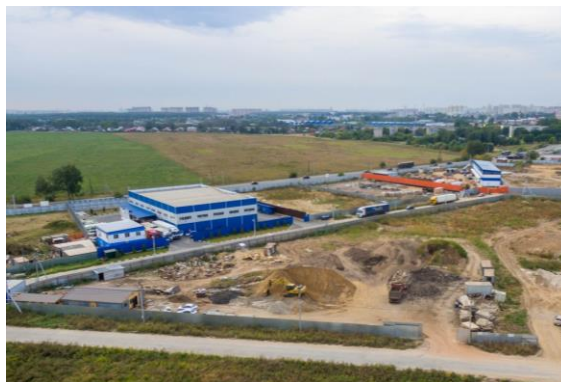
Фото 10. Общий вид земельных участков
