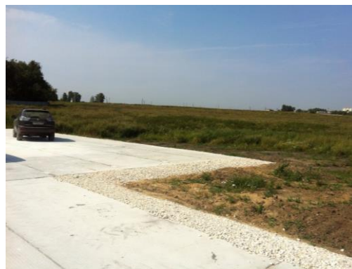
Фото 8. Общий вид земельных участков
