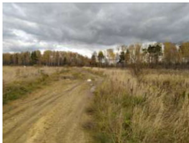
Фото 6. Общий вид подъездной дороги к объектам оценки
