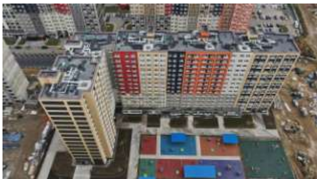
Фото 3. Общий вид ЖК «Пехра»
