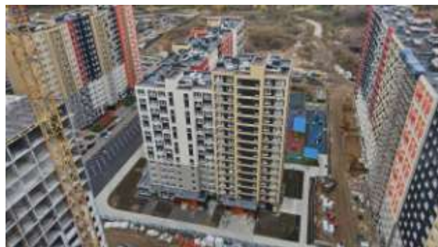
Фото 4. Общий вид ЖК «Пехра»
