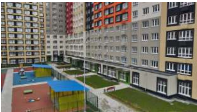
Фото 5. Общий вид ЖК «Пехра»
