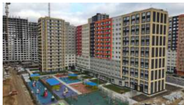
Фото 2. Общий вид ЖК «Пехра»
