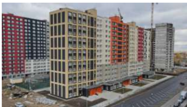
Фото 1. Общий вид ЖК «Пехра»
