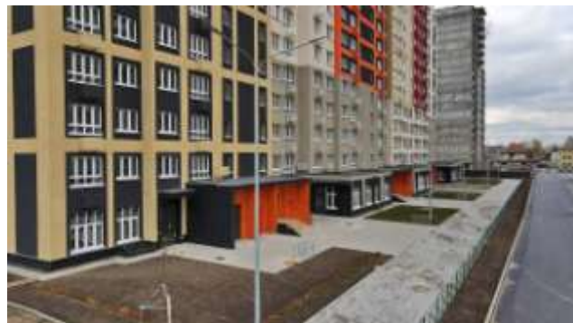
Фото 6. Общий вид ЖК «Пехра»
