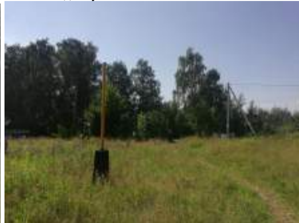
Фото 6. Вид на проходящие коммуникации – ЛЭП и газ
