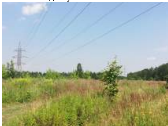
Фото 24. Вид на проходящие коммуникации - ЛЭП
