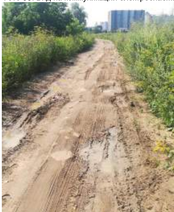
Фото 41. Вид на дорогу
