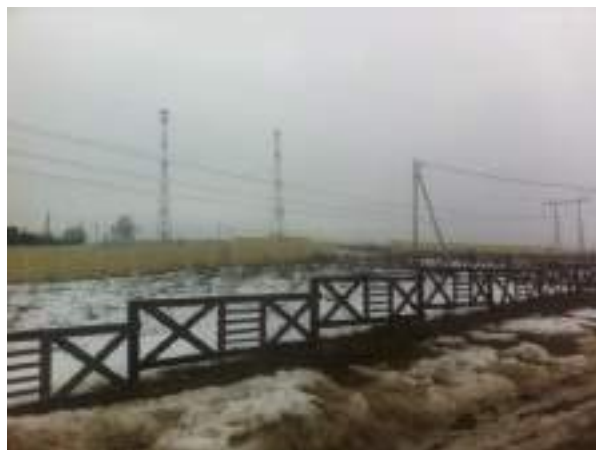
Фото 2. Расположение земельных участков вдоль ЛЭП 500 кВ.
