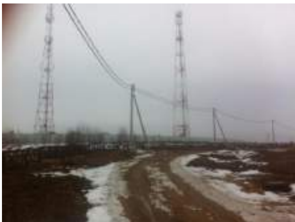
Фото 3. Расположение земельных участков вдоль ЛЭП 500 кВ.
