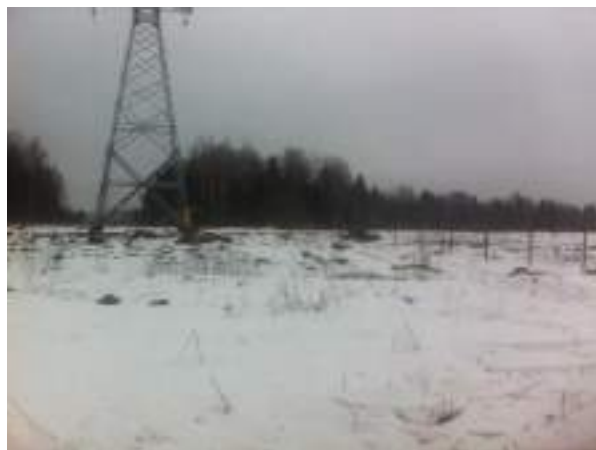
Фото 4. Расположение земельных участков вдоль ЛЭП 500 кВ.
