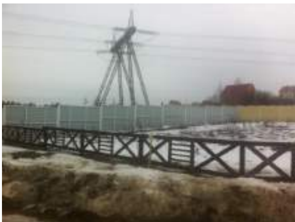
Фото 1. Расположение земельных участков вдоль ЛЭП 500 кВ.
