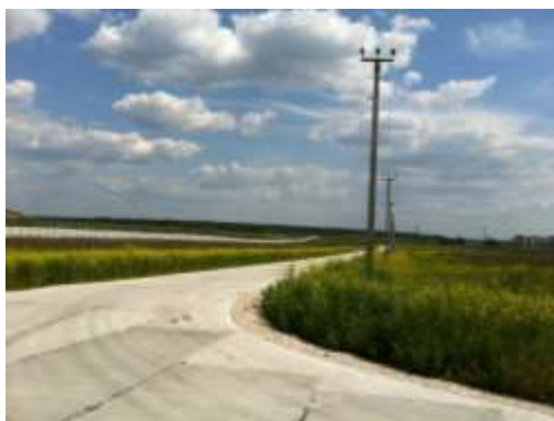
Фото 13. Подъездные пути к объектам оценки
