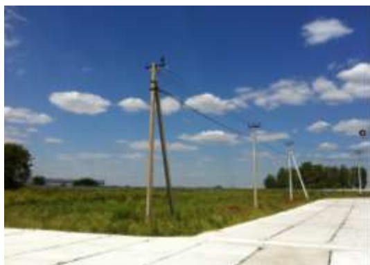
Фото 9. Подъездные пути к объектам оценки
