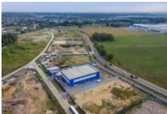
Фото 15. Подъездные пути к объектам оценки
