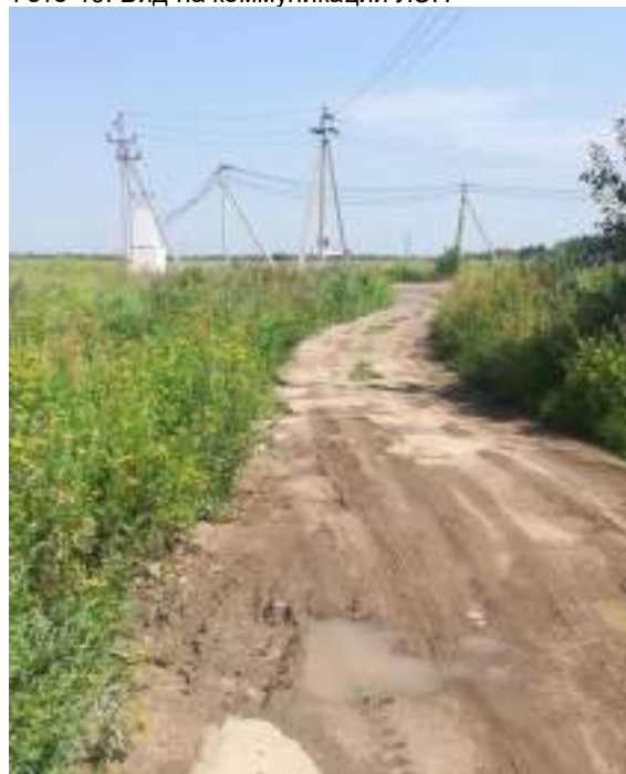
Фото 42. Вид на дорогу
