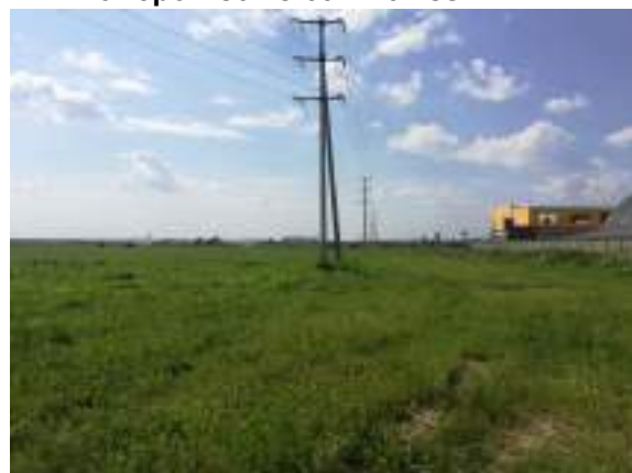
Фото 32. Вид на участок и ЛЭП
