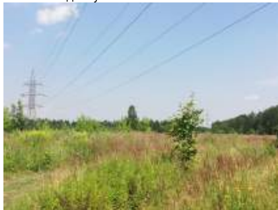
Фото 24. Вид на проходящие коммуникации - ЛЭП
