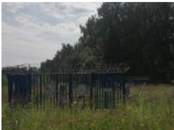
Фото 5. Вид на проходящие коммуникации - газ
