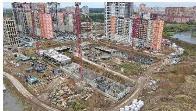
Фото 4. Общий вид корпуса 10.1 ЖК «Пехра»
