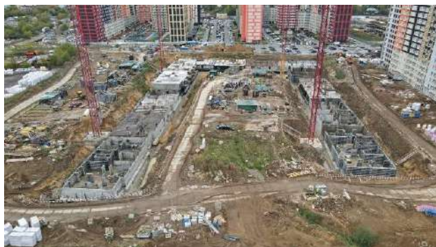
Фото 3. Общий вид корпуса 10.1 ЖК «Пехра»
