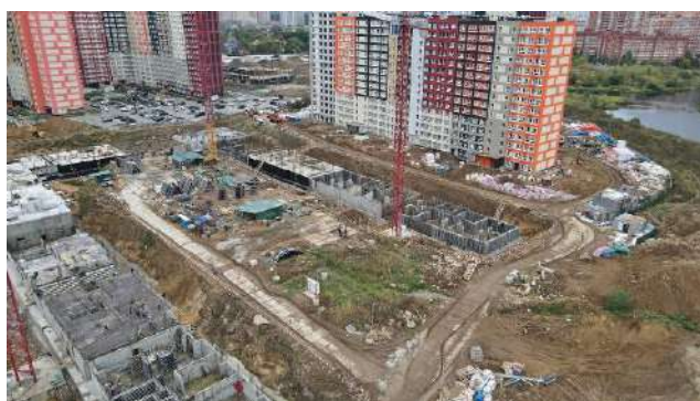
Фото 1. Общий вид корпуса 10.1 ЖК «Пехра»
