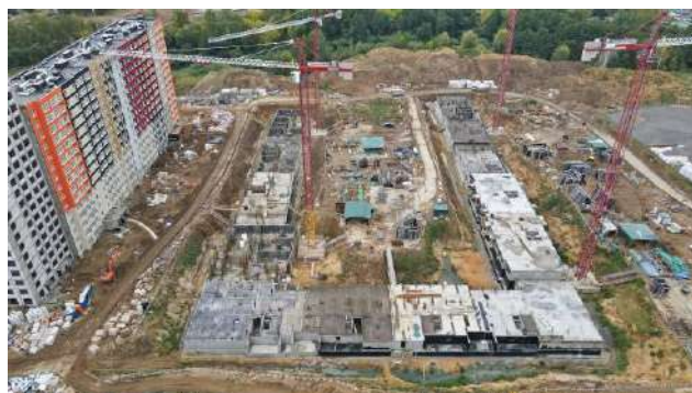
Фото 2. Общий вид корпуса 10 ЖК «Пехра»
