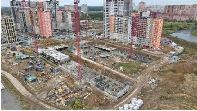
Фото 6. Общий вид корпуса 10 ЖК «Пехра»
