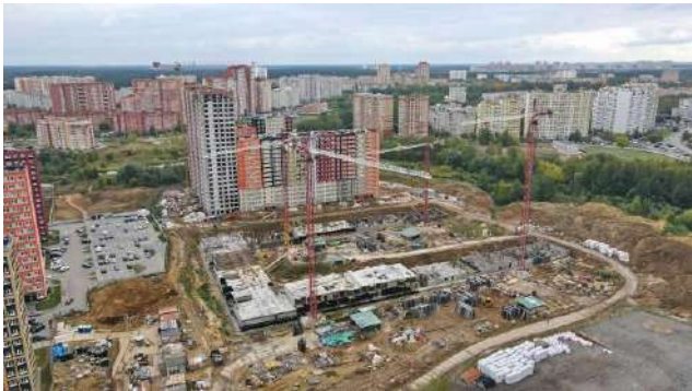
Фото 3. Общий вид корпуса 10 ЖК «Пехра»
