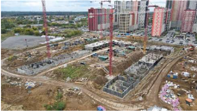
Фото 9. Общий вид корпуса 10 ЖК «Пехра»
