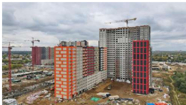
Фото 8. Общий вид корпуса 11 ЖК «Пехра»
