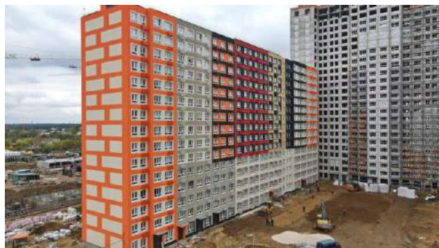
Фото 4. Общий вид корпуса 11 ЖК «Пехра»
