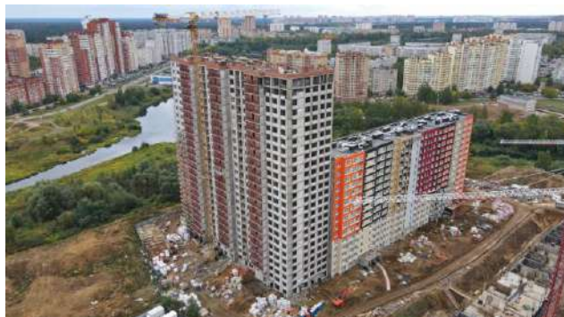
Фото 5. Общий вид корпуса 11 ЖК «Пехра»
