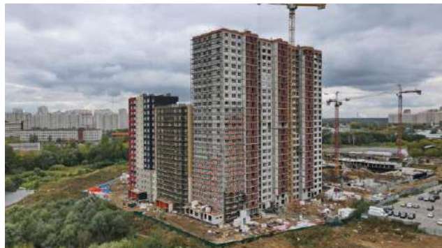
Фото 6. Общий вид корпуса 11 ЖК «Пехра»
