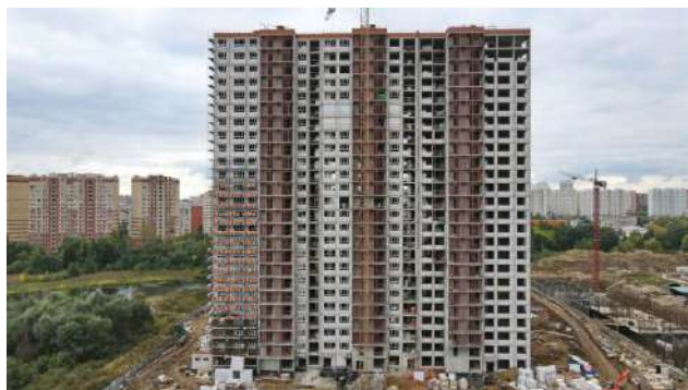
Фото 3. Общий вид корпуса 11 ЖК «Пехра»
