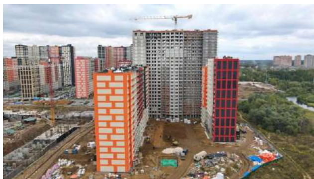
Фото 1. Общий вид корпуса 11 ЖК «Пехра»
