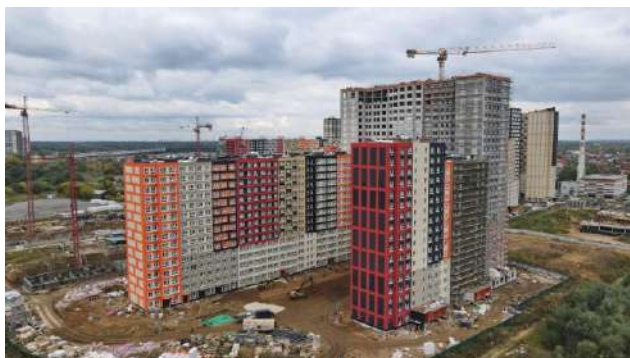
Фото 7. Общий вид корпуса 11 ЖК «Пехра»
