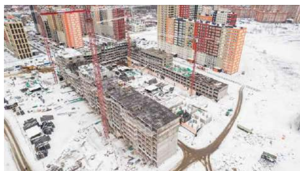
Фото 6. Общий вид корпуса 10 ЖК «Пехра»
