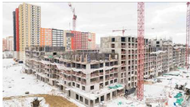
Фото 2. Общий вид корпуса 10 ЖК «Пехра»
