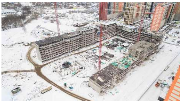
Фото 1. Общий вид корпуса 10 ЖК «Пехра»
