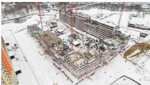
Фото 3. Общий вид корпуса 10 ЖК «Пехра»
