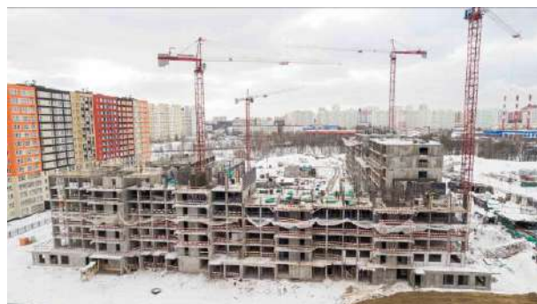
Фото 4. Общий вид корпуса 10 ЖК «Пехра»
