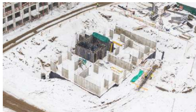
Фото 2. Общий вид корпуса 10.1 ЖК «Пехра»
