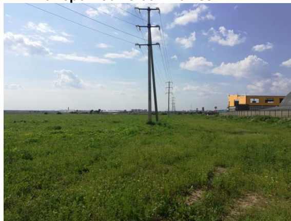
Фото 2. Вид на участок и ЛЭП
