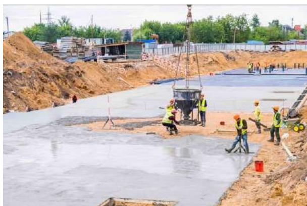
Фото 1. Общий вид корпуса 1 ЖК «Пехра»
