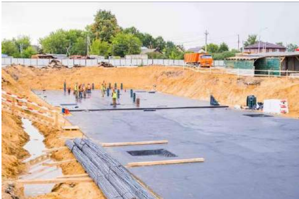
Фото 5. Общий вид корпуса 1 ЖК «Пехра»
