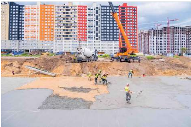
Фото 4. Общий вид корпуса 1 ЖК «Пехра»
