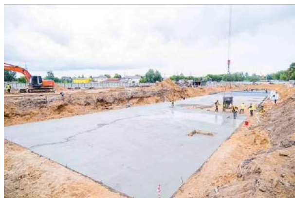
Фото 2. Общий вид корпуса 1 ЖК «Пехра»
