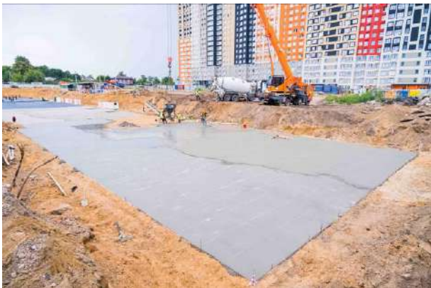
Фото 3. Общий вид корпуса 1 ЖК «Пехра»
