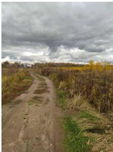
Фото 9. Общий вид подъездной дороги к объектам
