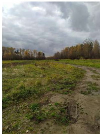
Фото 10. Общий вид подъездной дороги к объектам
