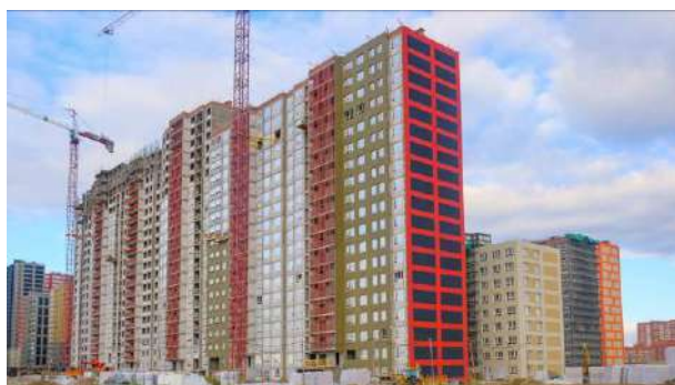
Фото 1. Общий вид корпуса 10 ЖК «Пехра»
