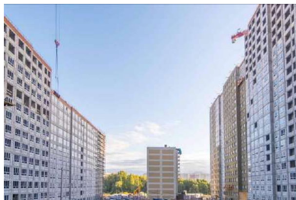
Фото 4. Общий вид корпуса 10 ЖК «Пехра»
