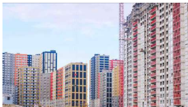
Фото 6. Общий вид корпуса 10 ЖК «Пехра»
