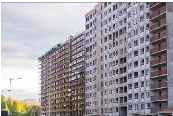
Фото 9. Общий вид корпуса 10 ЖК «Пехра»
