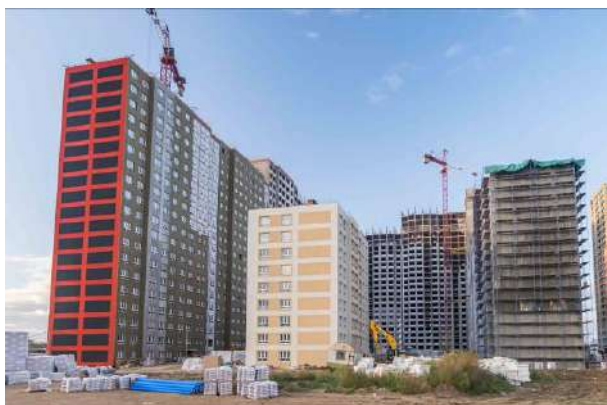
Фото 5. Общий вид корпуса 10 ЖК «Пехра»
