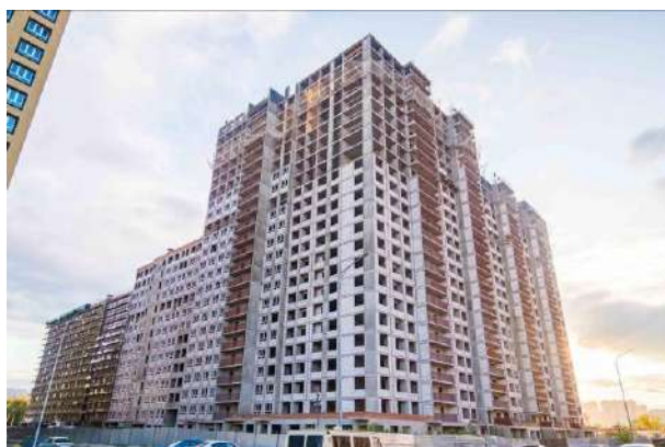
Фото 7. Общий вид корпуса 10 ЖК «Пехра»
