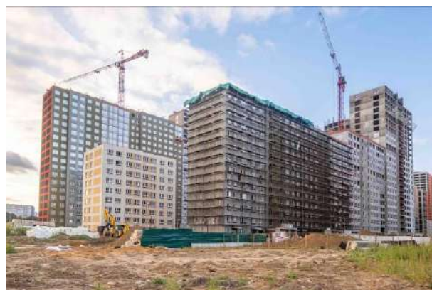
Фото 8. Общий вид корпуса 10 ЖК «Пехра»
