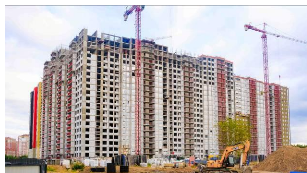
Фото 10. Общий вид корпуса 10 ЖК «Пехра»
