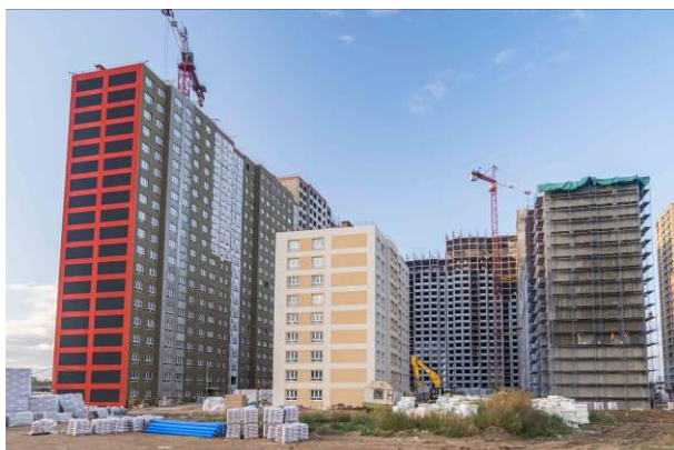
Фото 5. Общий вид корпуса 10 ЖК «Пехра»
