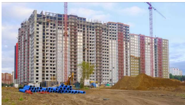
Фото 3. Общий вид корпуса 10 ЖК «Пехра»
