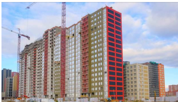
Фото 1. Общий вид корпуса 10 ЖК «Пехра»
