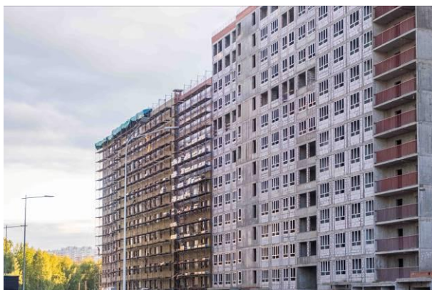
Фото 9. Общий вид корпуса 10 ЖК «Пехра»
