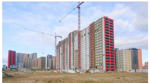
Фото 2. Общий вид корпуса 10 ЖК «Пехра»
