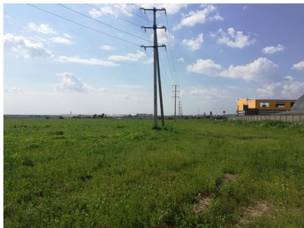
Фото 2. Вид на участки и ЛЭП
