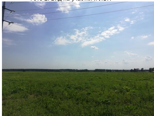
Фото 4. Вид на участки и ЛЭП
