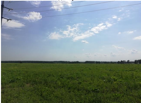
Фото 4. Вид на участок и ЛЭП
