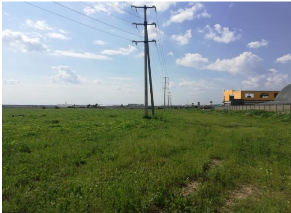
Фото 2. Вид на участок и ЛЭП
