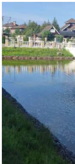
Фото. Общий вид объекта оценки с КН: 50:14:0040120:491
