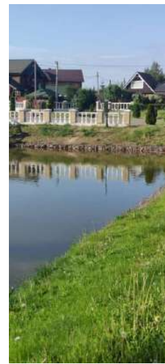
Фото. Общий вид объекта оценки с КН: 50:14:0040120:491
