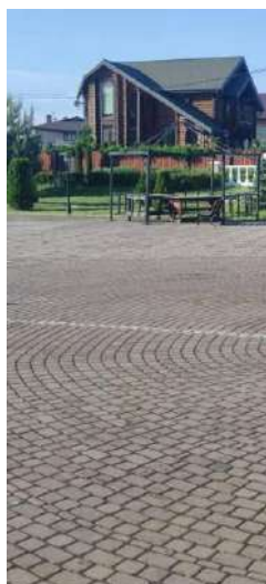
Фото. Общий вид объекта оценки с КН: 50:14:0040120:491
