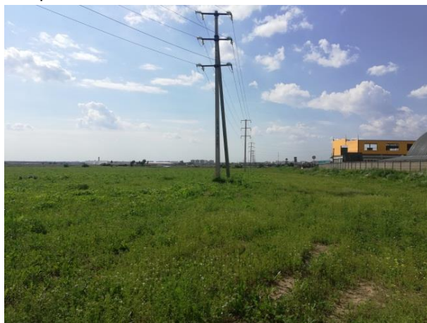
Фото 2. Вид на участки и ЛЭП
