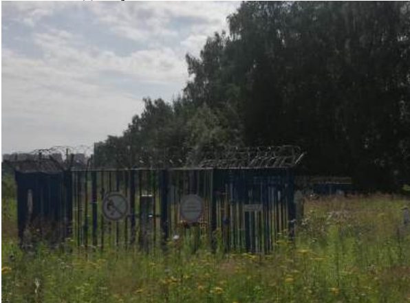
Фото 5. Вид на проходящие коммуникации - газ
