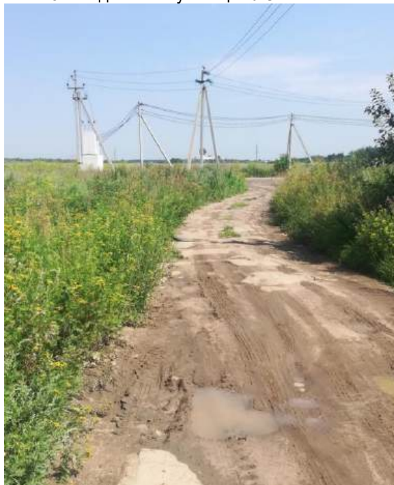
Фото 34. Вид на дорогу
