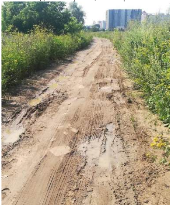
Фото 33. Вид на дорогу
